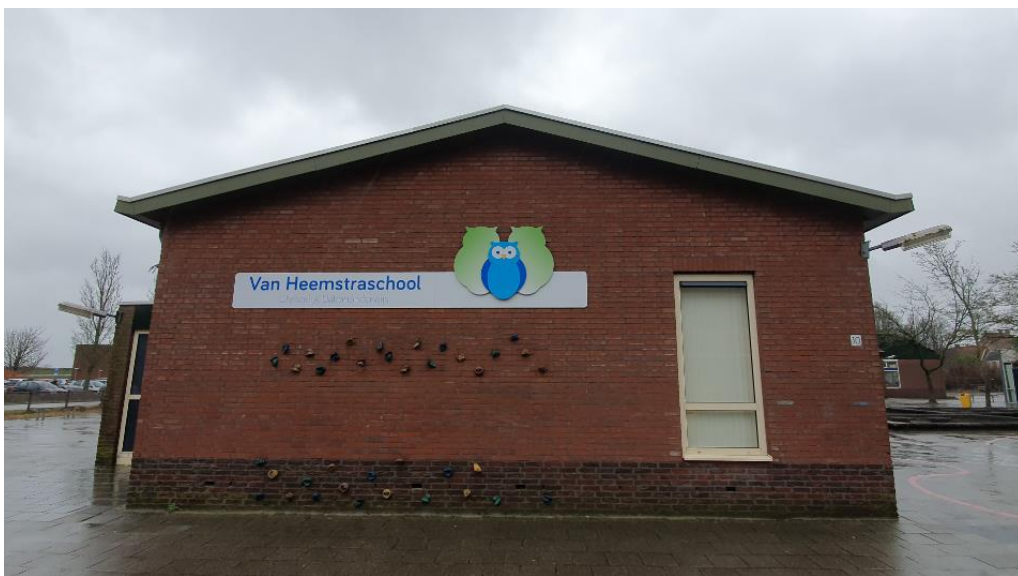
Figuur 2 De Van Heemstraschool opgetrokken uit gemetselde muren en zadeldak.
