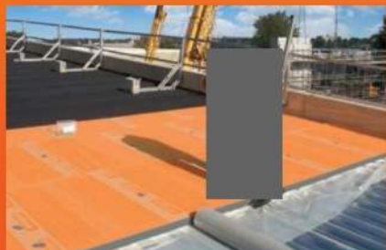
plat dak isolatie
