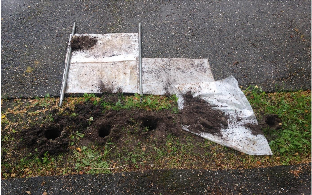
Boring 6 – na 4 pogingen gestaakt.
