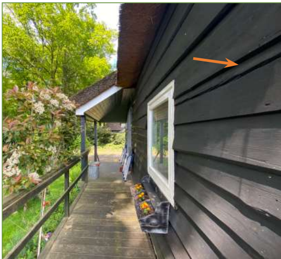
Afb. 2.9 en 2.10 - Achter de wijkende en gescheurde, gepotdekselde schaaldelen kunnen zich mogelijk verblijfplaatsen van vleermuizen bevinden.
