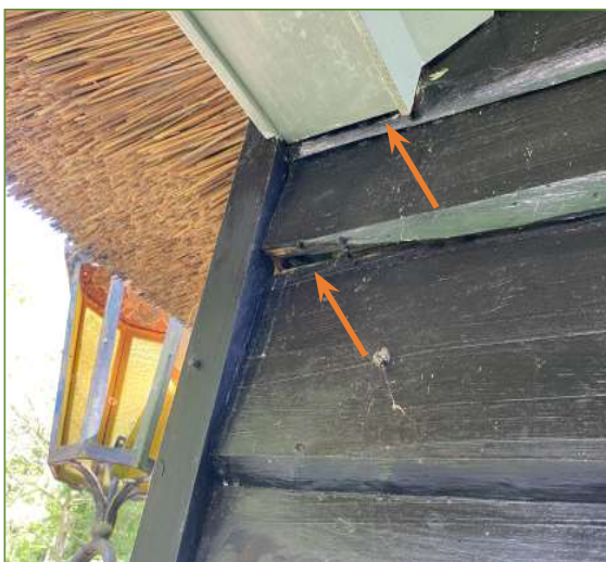
Afb. 2.11 en 2.12 - Scheuren en kieren kunnen toegang geven tot verblijfplaatsen van vleermuizen. De opening onder het afdak bij de voordeur geeft toegang tot de zolderruimte, welke voor Gewone grootoorvleermuis geschikt kan zijn.
