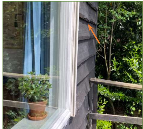
Afb. 2.9 en 2.10 - Achter de wijkende en gescheurde, gepotdekselde schaaldelen kunnen zich mogelijk verblijfplaatsen van vleermuizen bevinden.
