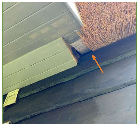
Afb. 2.11 en 2.12 - Scheuren en kieren kunnen toegang geven tot verblijfplaatsen van vleermuizen. De opening onder het afdak bij de voordeur geeft toegang tot de zolderruimte, welke voor Gewone grootoorvleermuis geschikt kan zijn.
