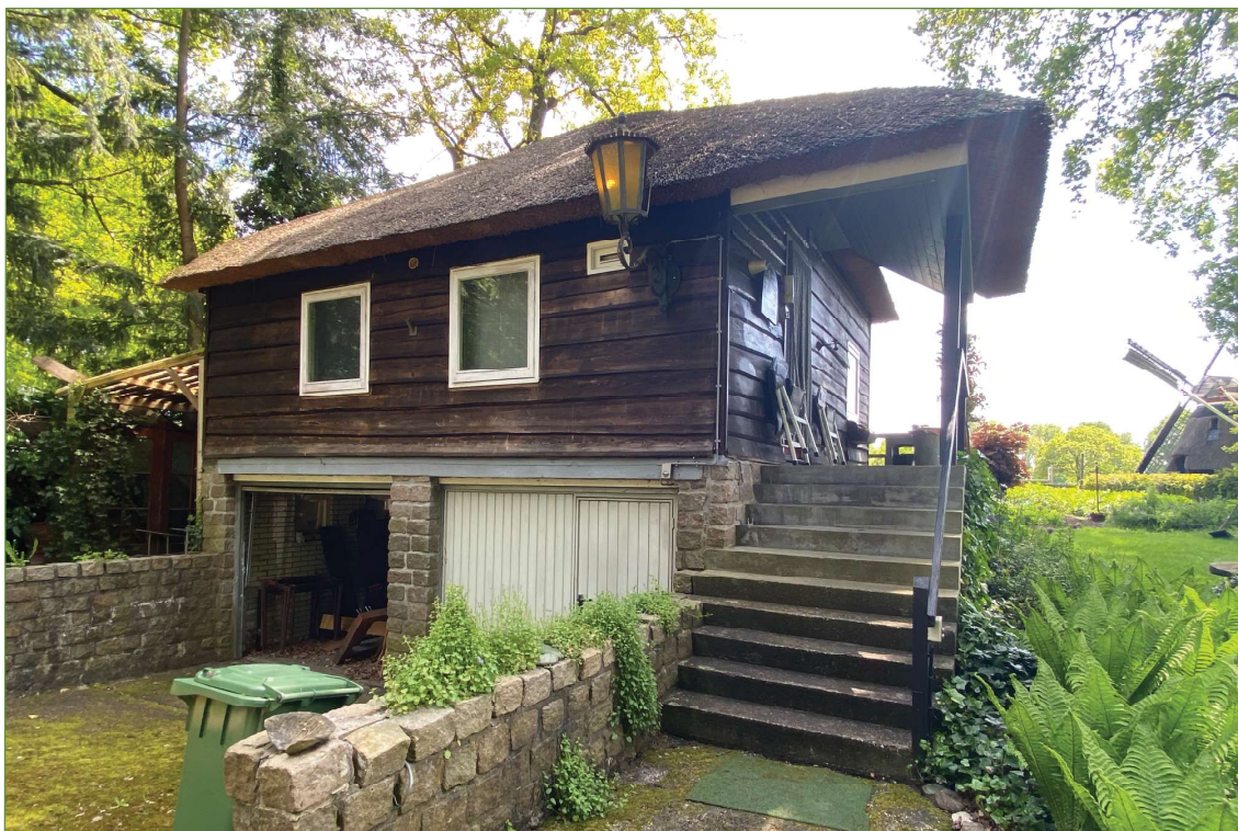
Afb. 1.4 - Noordzijde recreatiewoning met de twee garages en links de aanbouw. De trap geeft toegang tot de voordeur en de veranda. Opnamedatum: 19 mei 2023
