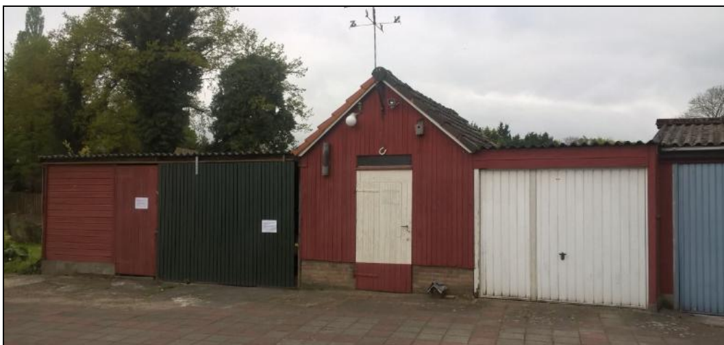
Figuur 4.1-1: Te slopen schuren/garages in het plangebied.
