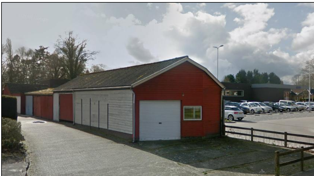
Figuur 4.1-2: Te slopen schuren/garages in het plangebied.
