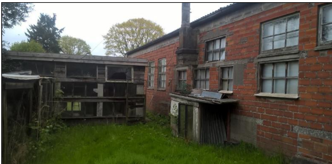
Figuur 4.1-3: Te slopen schuren in het plangebied.
