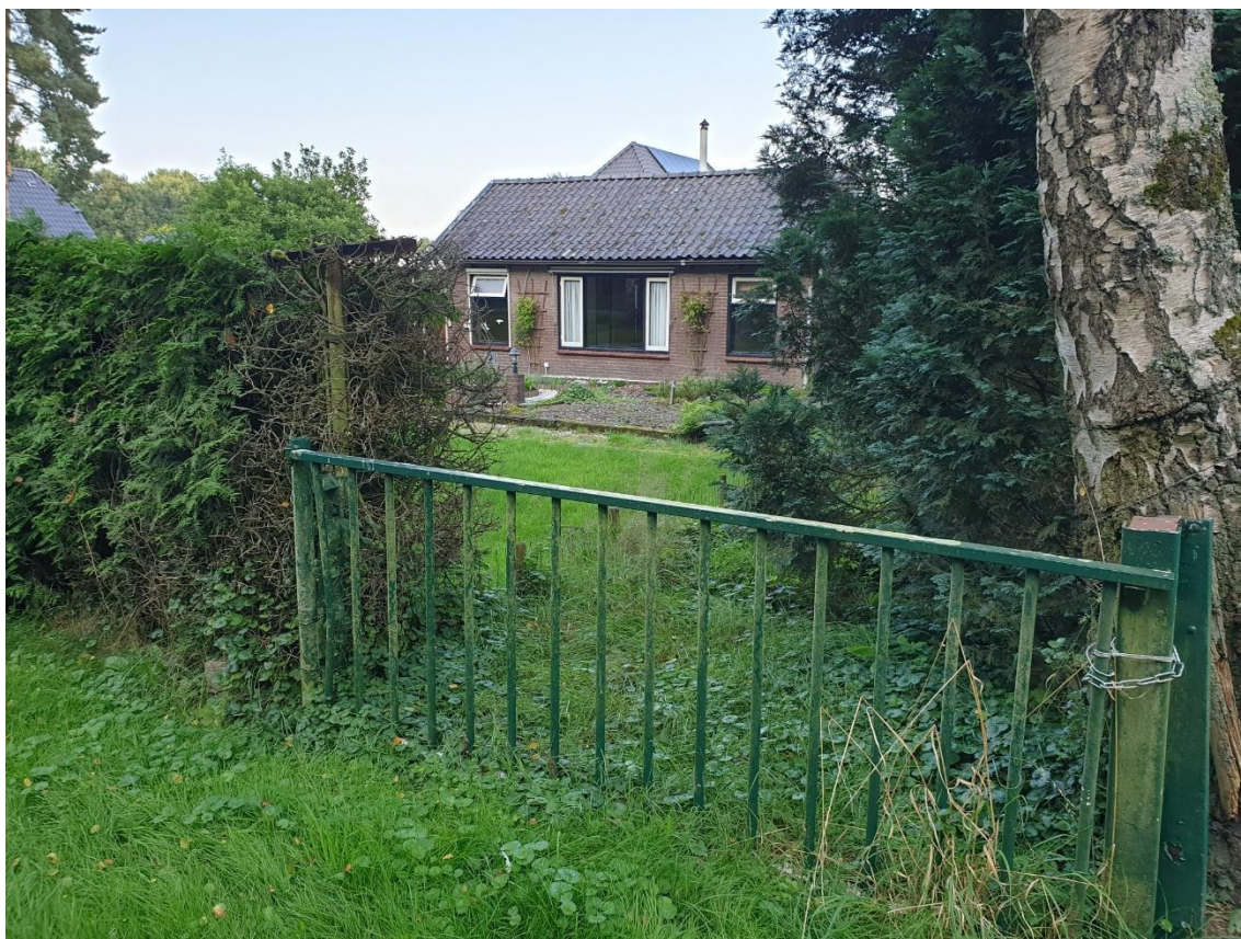
Afbeelding 4: Verouderde te slopen woning Parallelweg 8.
