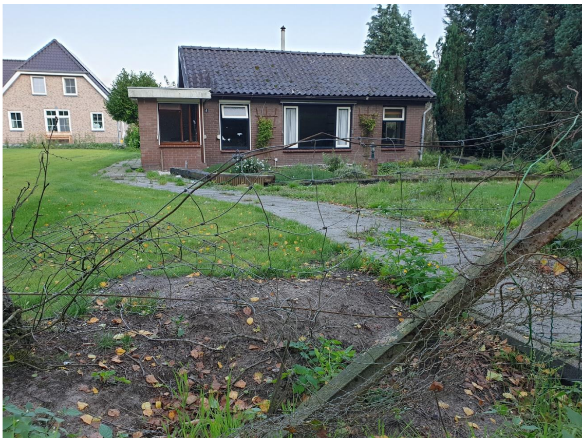
Afbeelding 3: Vooraanzicht Parallelweg 7 (links) en Parallelweg 8 (rechts) vanaf de Parallelweg gezien.
