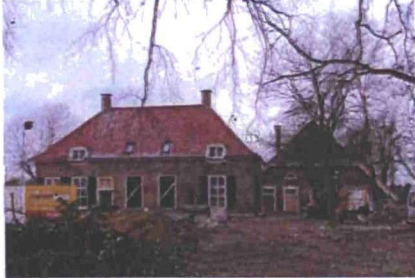
Figuur 8: Traditionele opzet hoofdgebouw en bijgebouw (De Middenhof, Twello)
