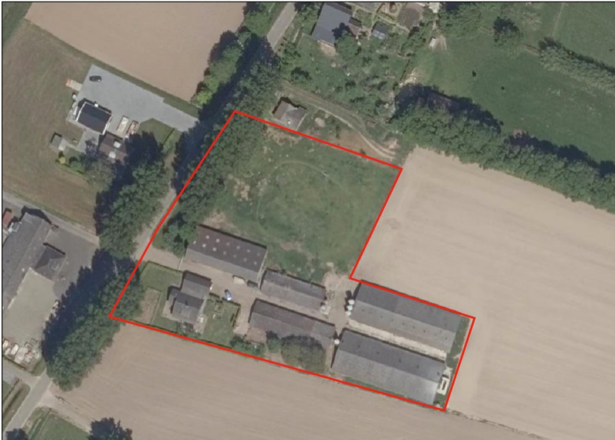
Afbeelding 2.1 Luchtfoto plangebied (Bron: PDOK, bewerkt)
