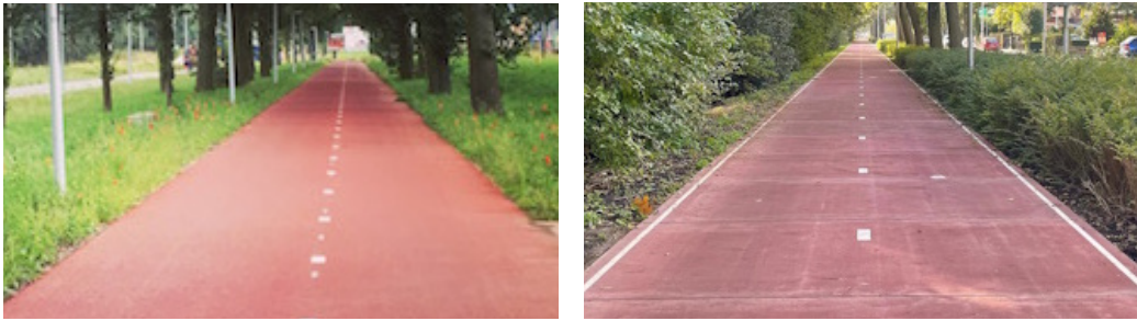
Fietspad met gesloten verharding. Asfalt of beton
