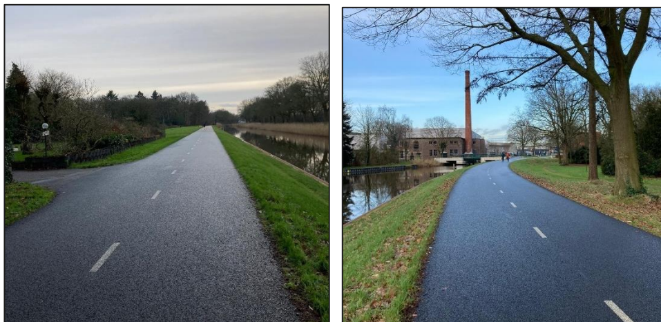
Figuur 4.2: Kanaaldijk richting het zuiden (links) en noorden (rechts) (foto's: Goudappel)
