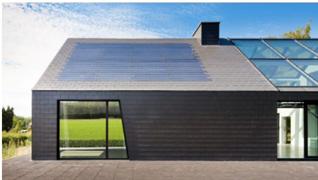
Zonnepanelen integreren in het dakvlak
