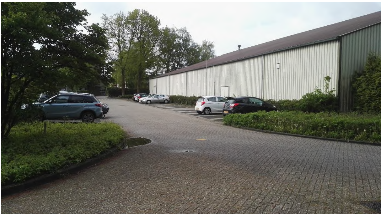
Figuur 14: Tennishal (oostzijde), gefotografeerd tegen zuiden.
