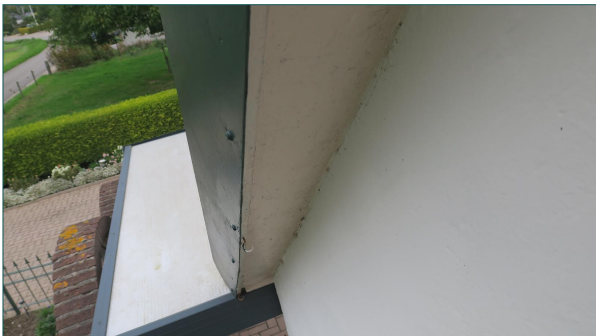
Figuur 3.2 Bij een inspectie aan het dak zijn geen openingen aangetroffen waar vleermuizen gebruik van kunnen maken. De windveer sluit strak aan op het afgewerkte stucwerk.
