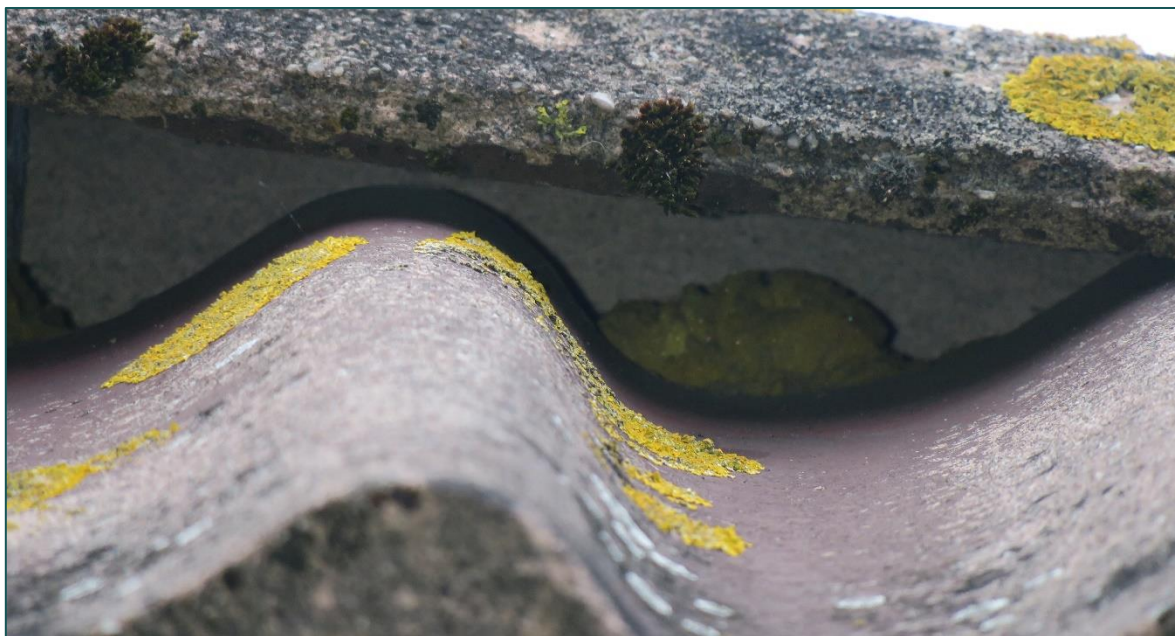
Figuur 3.3 Bij de nokvorst is de aanwezigheid van purschuim goed te zien. Dit is ook ter hoogte van de dakvoet aangebracht.
