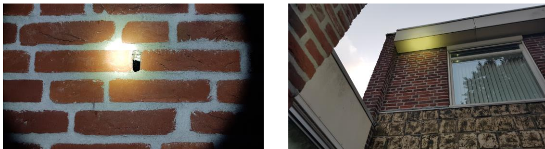
Figuur 4.1. Openingen en kieren in de bebouwing die toegang bieden tot potentiële verblijfplaatsen voor vleermuizen.
