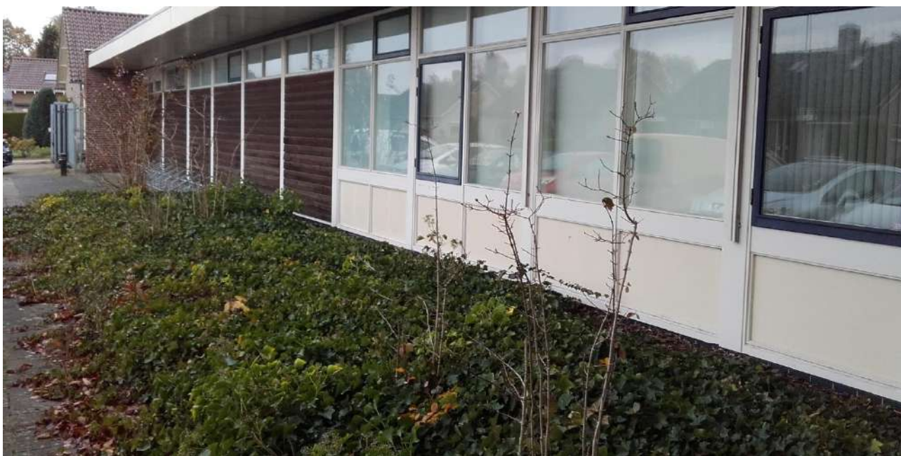
Afbeelding 2.2: Huidige situatie van de zuidzijde van het politiebureau (foto: Greenhouse Advies).
