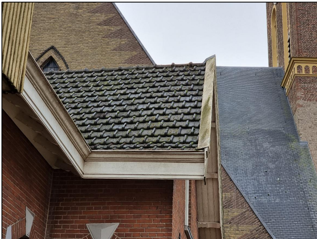
Figuur 2 Het dak van de woning bevat platte en zeer nauw sluitende dakpannen, ongeschikt voor huismusnesten.
