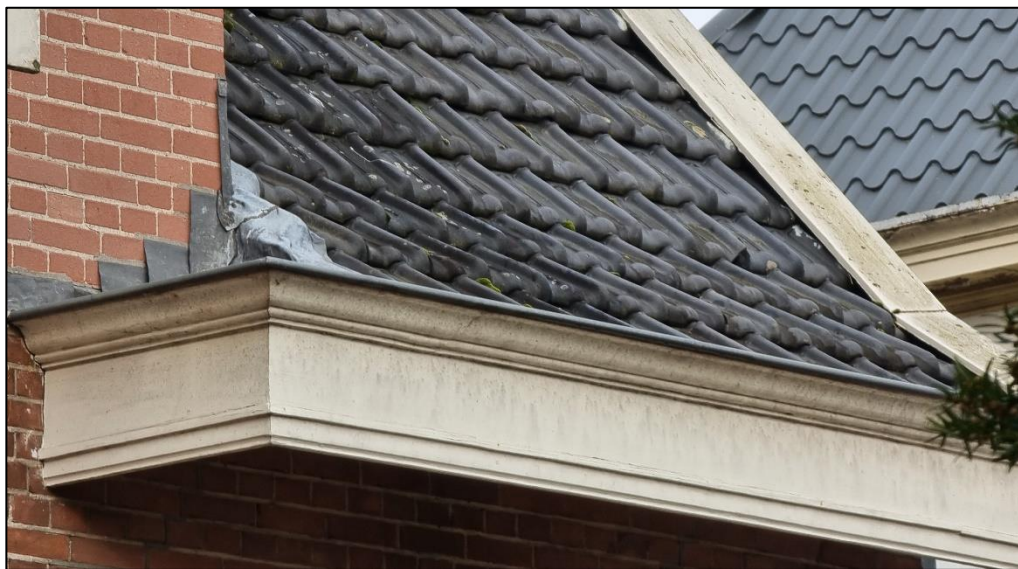
Figuur 5 Weergave van de aanwezige dakpannen, plat en zeer nauwsluitend waardoor er geen toegang tot onder de dakpannen wordt geboden.
