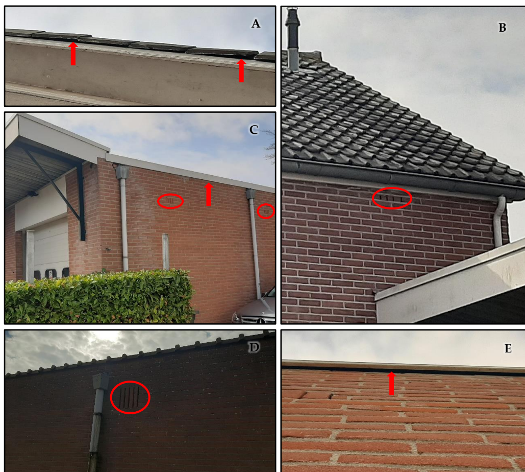
Figuur 4 Diverse structuren in de woningen en bedrijfsbebouwing welke vleermuizen mogelijk toegang bieden tot een verblijfplaats. A) (beperkte) kierende kantpannen in woning A; B) ventilatieroosters in woning B; C) ventilatieroosters en kierende boeidelen in de garage van woning B; D) ventilatieroosters in gebouw E; E) kierende boeidelen in gebouw E.
