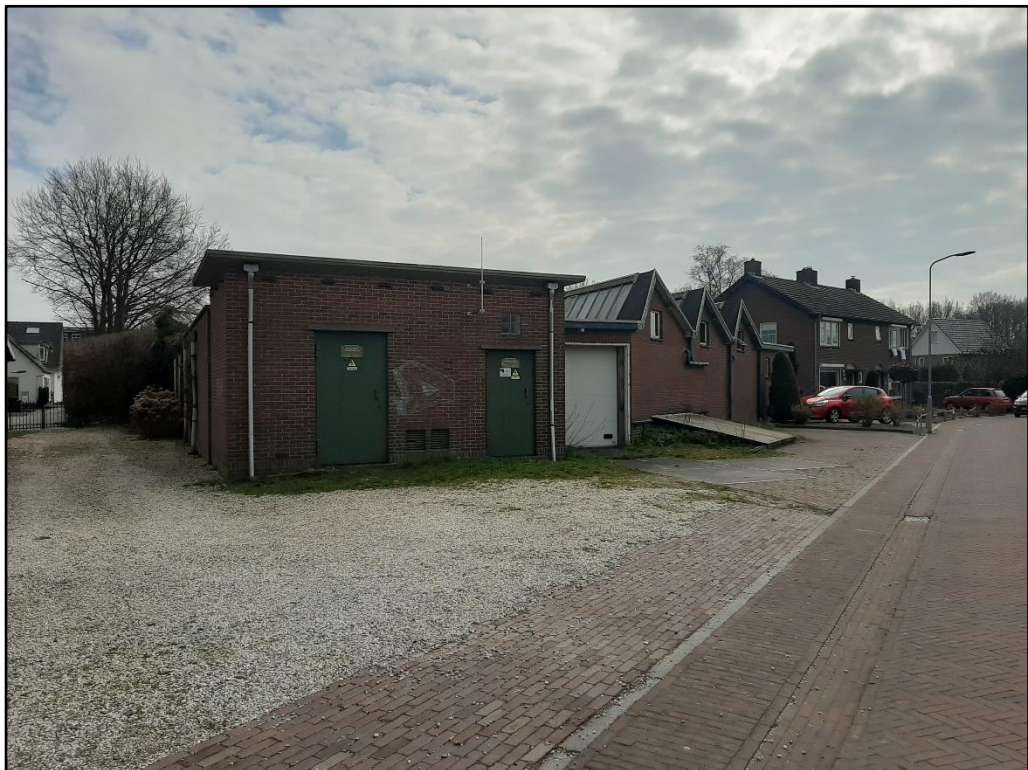
Figuur 4 Gebouw D gezien vanuit het noordwesten met het transformator huisje
