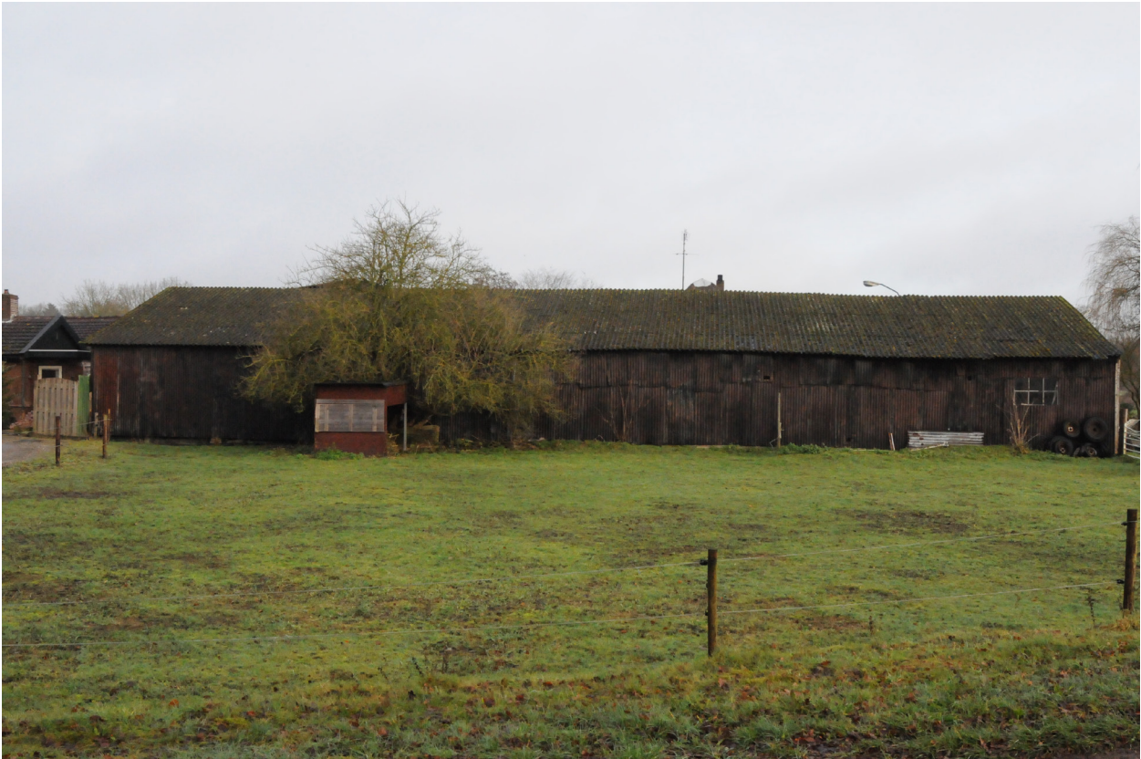
Afbeelding 6. Zicht op het zuidelijke begebouw vanaf de Wezeweg.
