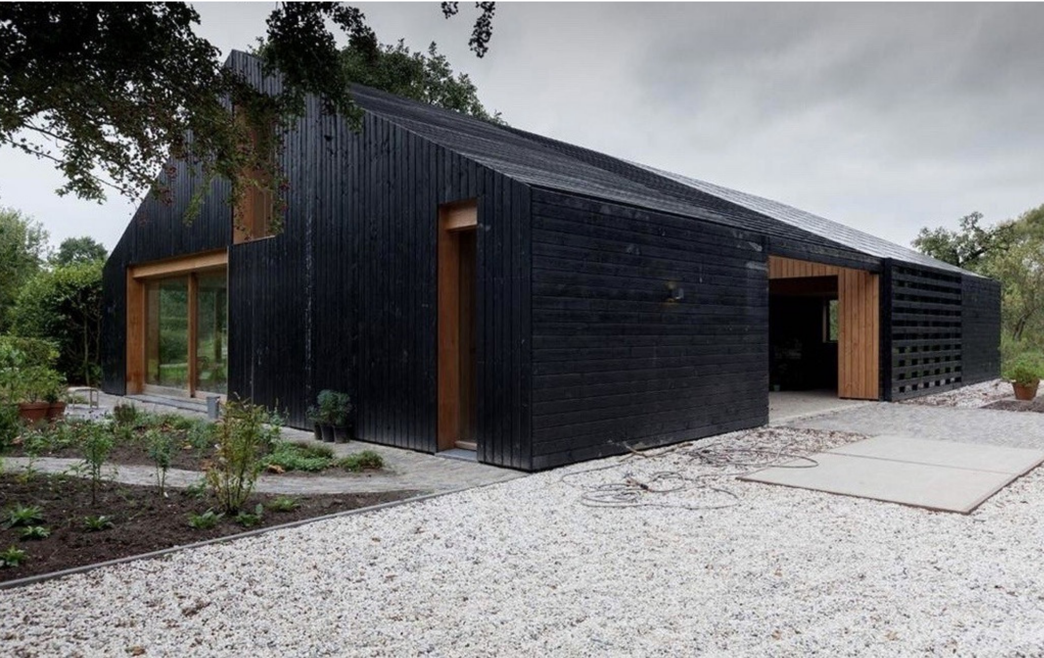
Referentiebeeld, Schipperdouwes architectuur - schuurwoning Delden. Sobere uitstraling, houten begeveling, enkele kap
