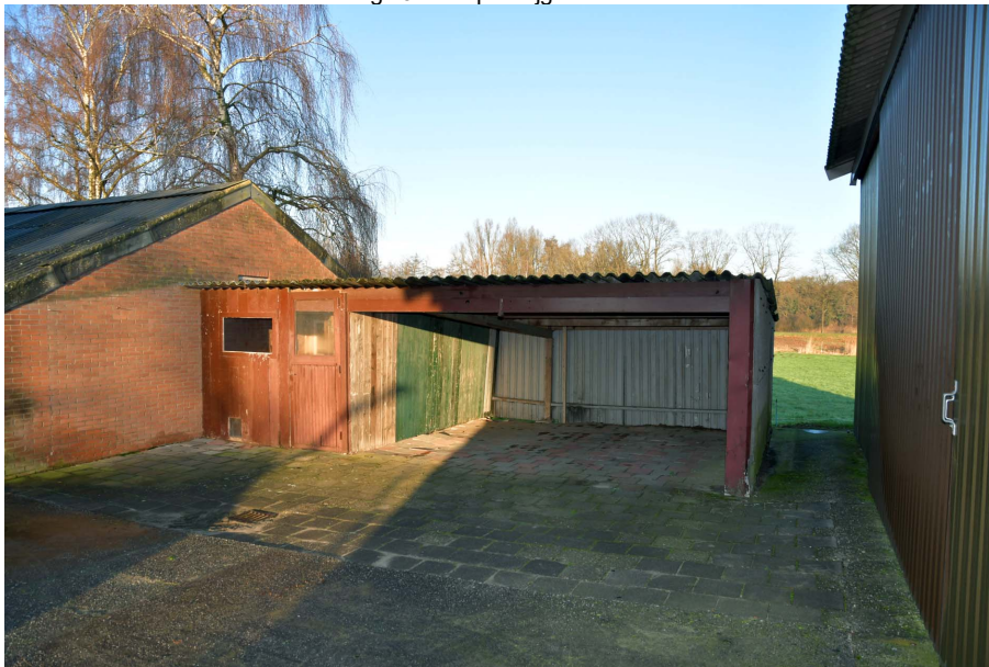
• Afbeelding 19: te slopen bijgebouw
