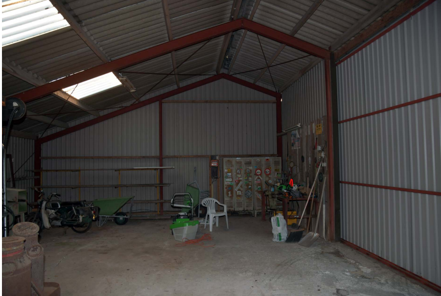
• Afbeelding 18: binnenzijde schuur
