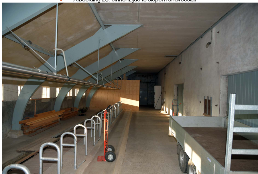
• Afbeelding 23: binnenzijde te slopen rundveestal
