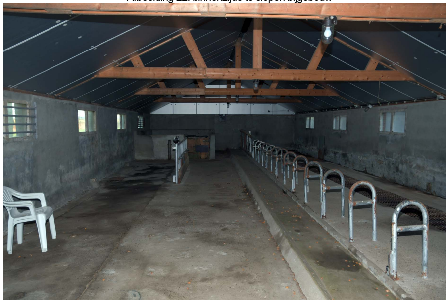
• Afbeelding 22: binnenzijde te slopen bijgebouw
