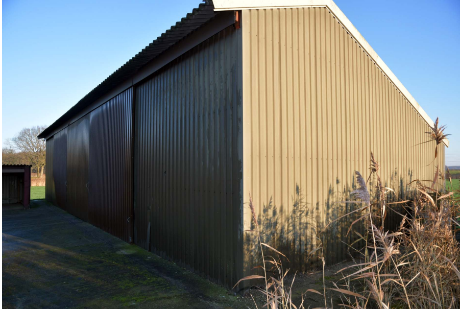
• Afbeelding 16: te slopen schuur achterzijde perceel
