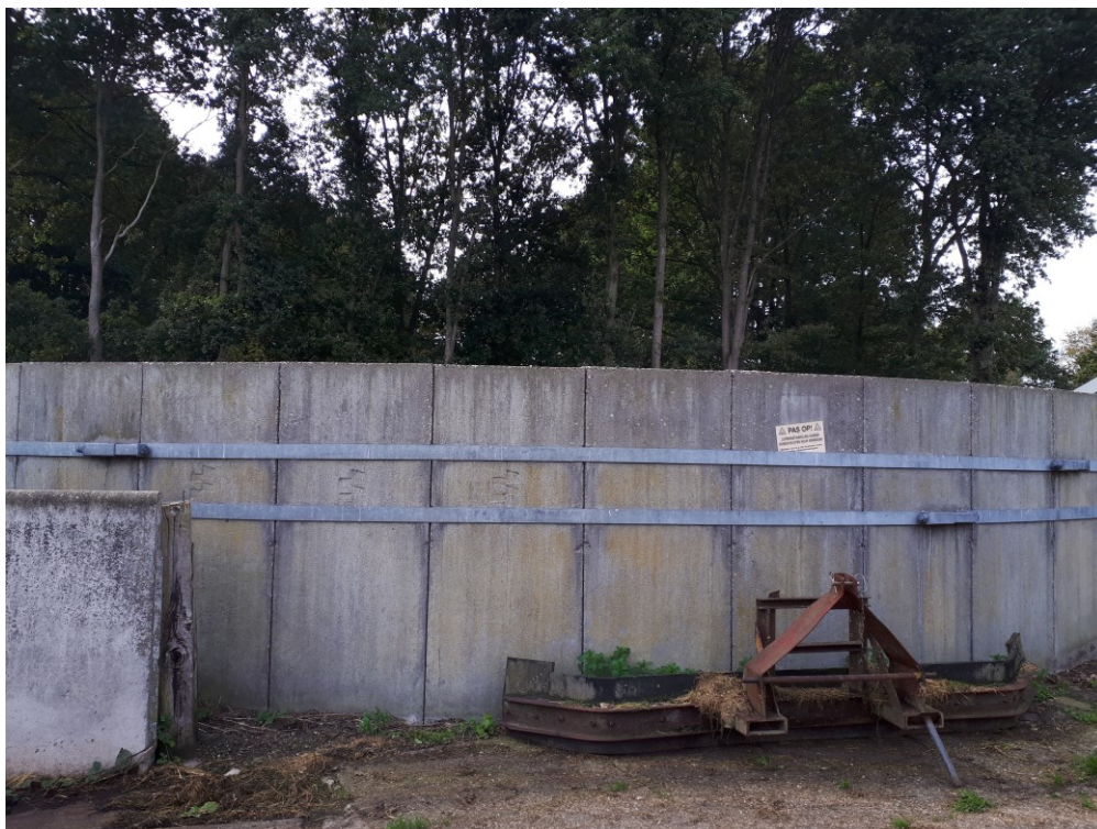
Buitenopslag achter bestaande schuur
