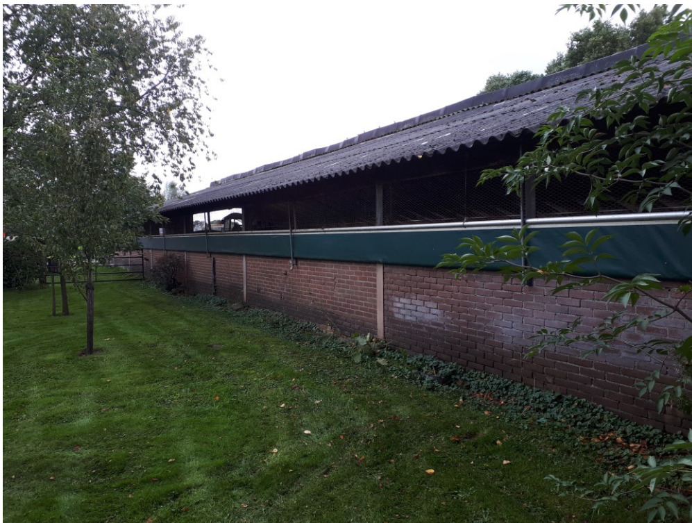
Zijgevel oostzijde bestaande schuur
