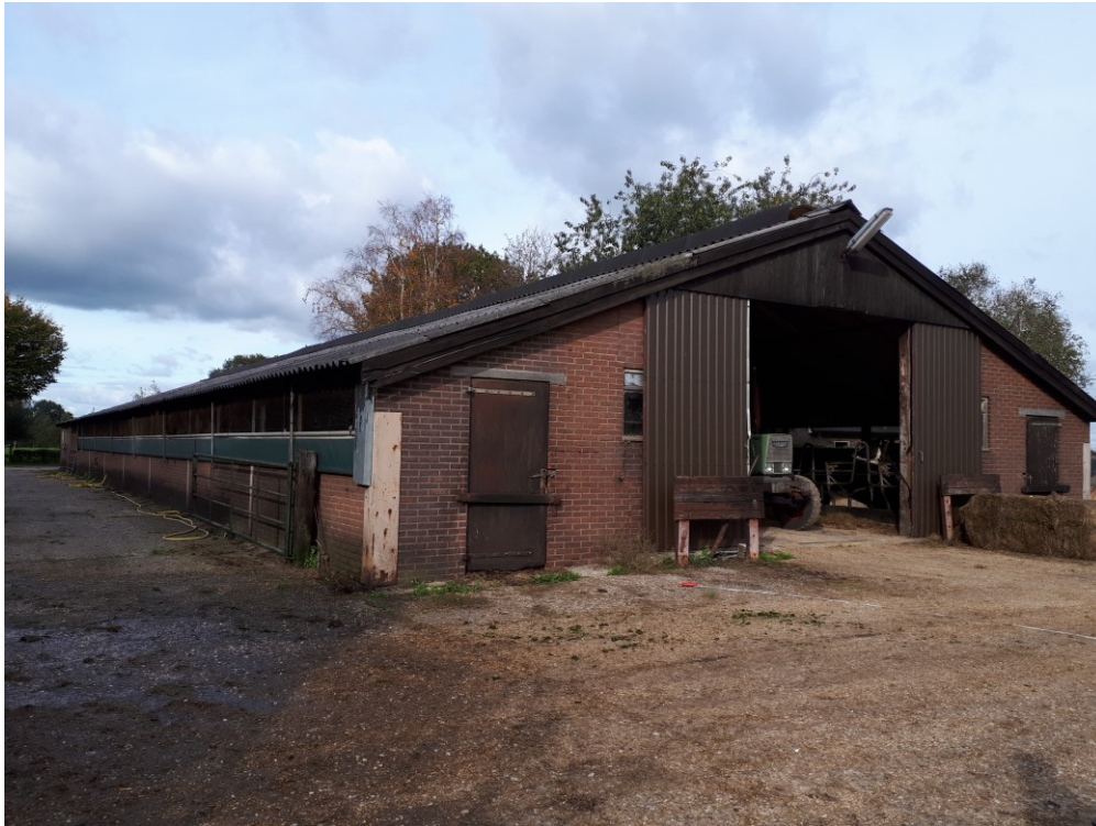
Achtergevel bestaande schuur, gezien vanuit zuidelijke richting
