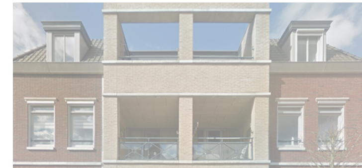
Metselwerk overheerst in het gevelbeeld.
