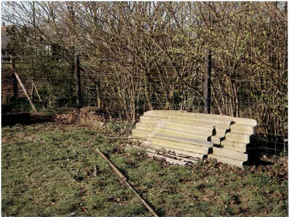
Foto asbestverdachte golfplaten
