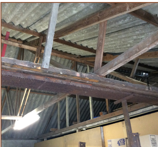
Afb. 3.3: Binnenzijde dakconstructie schuur. Er zijn geen vogelnesten of verblijfplaatsen van vleermuizen aangetroffen.
