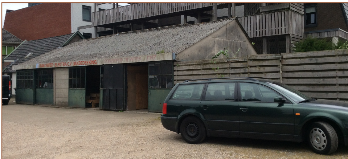
Afb. 3.2: Te slopen voormalige werkschuur.
