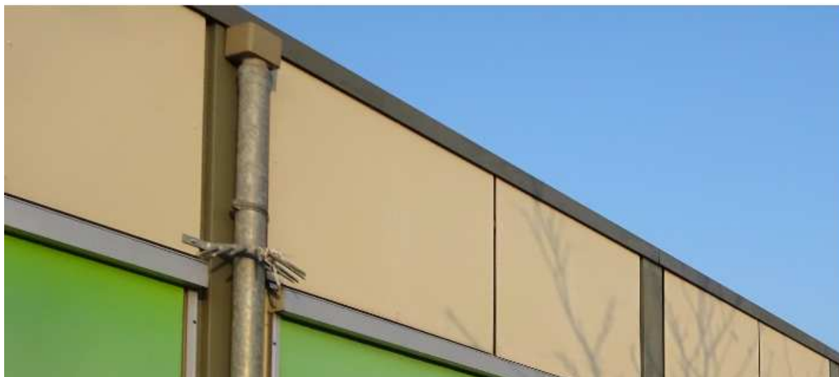
Figuur 5.2 Naadloos afgewerkte dakrand.
