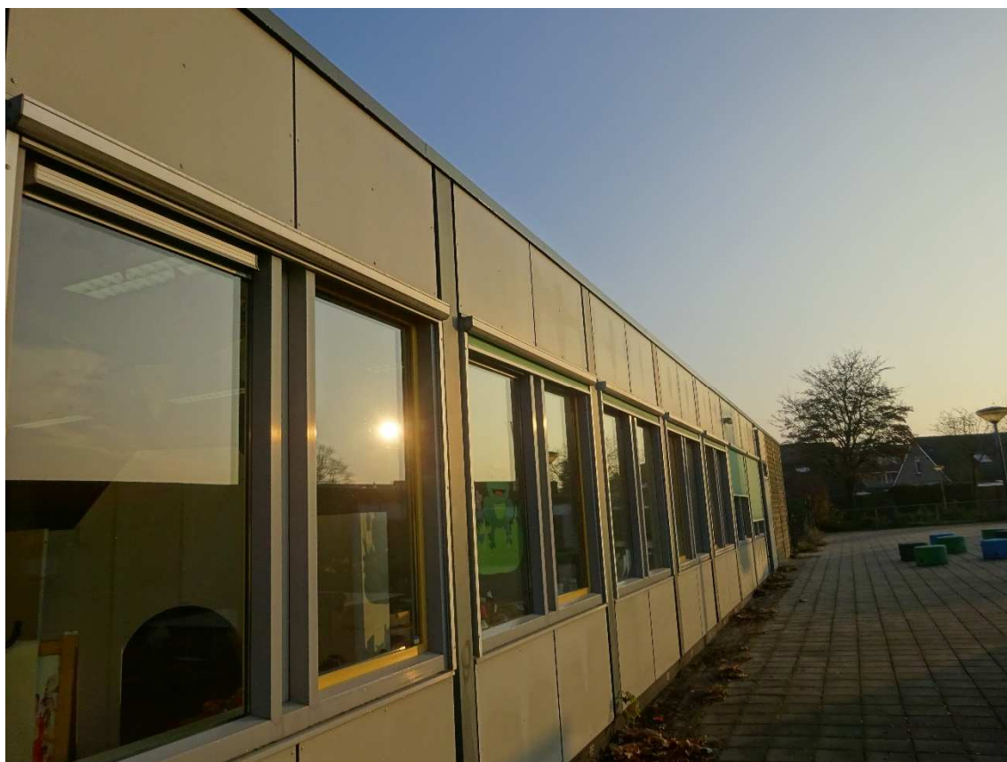
Figuur 2.5. Noordzijde van de onderzoekslocatie.
