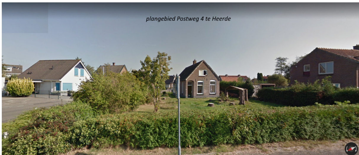
Afbeelding 1.1: Het plangebied – te slopen huis met tuin - te Heerde (bron: Google - streetview).
