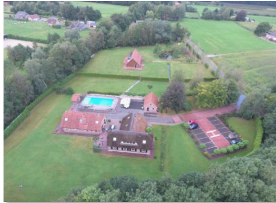
Figuur 2: Huidige bebouwing Eikenlaan 1
