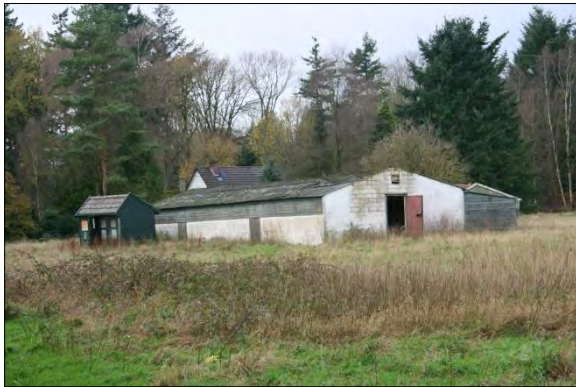
De bestaande opstallen (gedeeltelijk met asbest) worden gesloopt.
