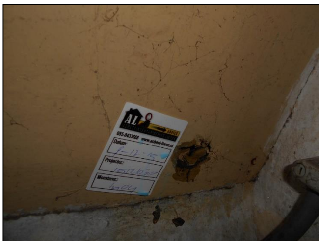
Foto 33: Woning 2: Bergruimte: Vlakke plaat (M04AA)
