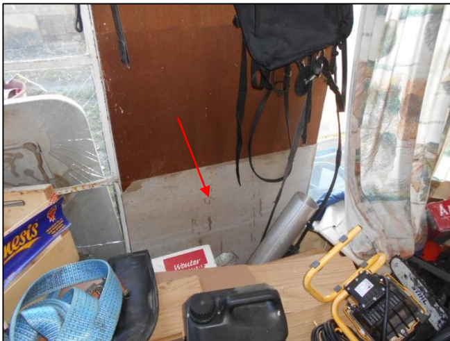
Foto 49: Schuur 1: Binnenzijde: Vlakke plaat (M04AZ)
