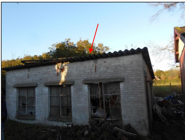
Foto 69: Schuur 3: Golfplaten dak (M03AZ)
