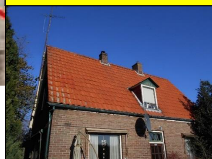
Woning 1: Dakbeschot en zijwangen (M02AA)
