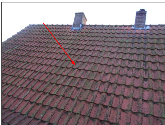
Foto 13: Woning 1: Dakbeschot (M02AA)
