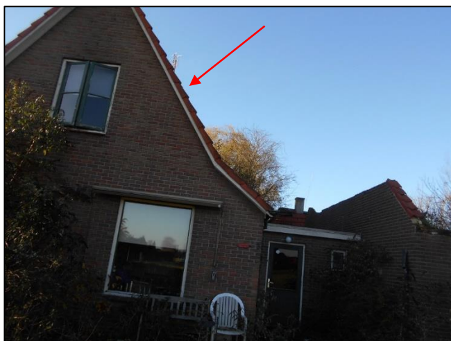
Foto 15: Woning 1: Dakbeschot (M02AA)
