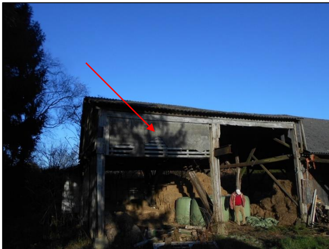
Foto 61: Schuur 2: Buitenzijde: Wandbeplating (M04AZ)
