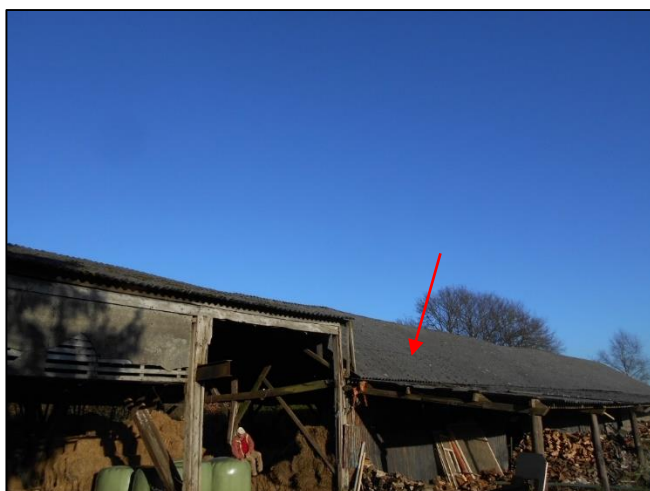
Foto 65: Schuur 2: Golfplaten dak (M03AZ)
