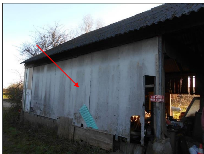
Foto 60: Schuur 2: Buitenzijde: Wandbeplating (M04AZ)
