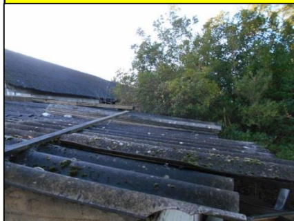
Houtopslag: Golfplaten dak (M04AZ)
