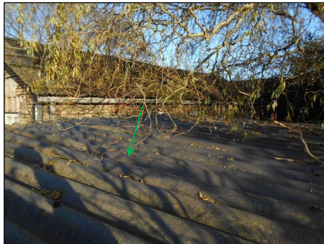
Foto 68: Schuur naast woning 4: Golfplaten dak (Asbestvrij)
