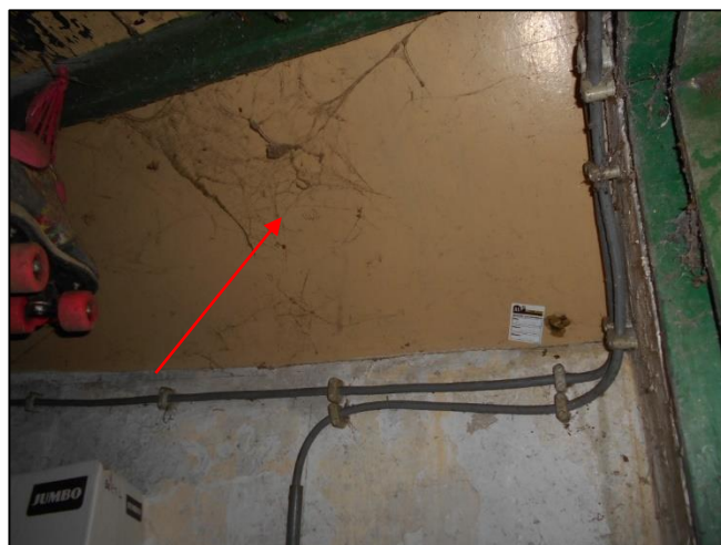
Foto 34: Woning 2: Bergruimte: Vlakke plaat (M04AA)
