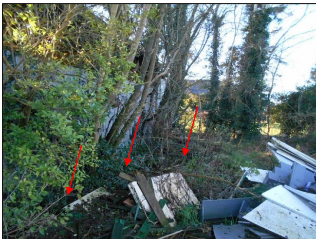
Foto 63: Naast schuur 2: Restanten wandbeplating (M04AZ)
