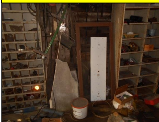
Binnenzijde schuur 2: Restant vlakke plaat (Los) (M04AZ)
