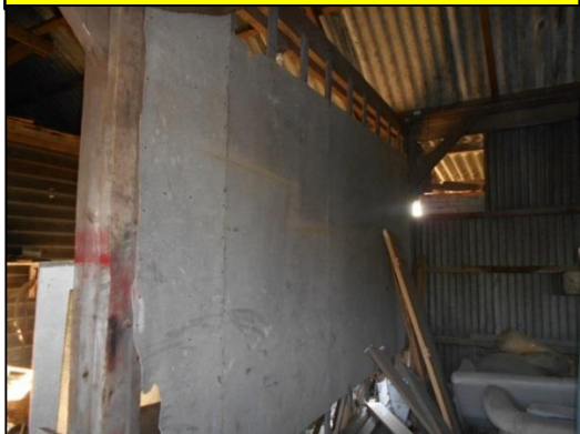
Binnenzijde schuur 2: Wandbeplating (M04AZ)
