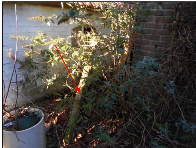
Foto 8: Naast afgebrande woning: Buis (M01AZ)
