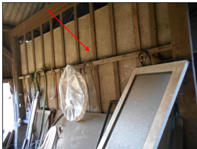
Foto 56: Schuur 2: Binnenzijde: Wandbeplating (M04AZ)
