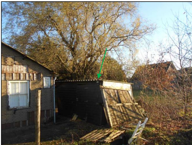
Foto 67: Schuur naast woning 4: Golfplaten dak (Asbestvrij)
