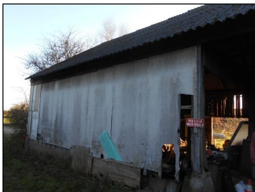
Buitenzijde schuur 2: Wandbeplating (M04AZ)
