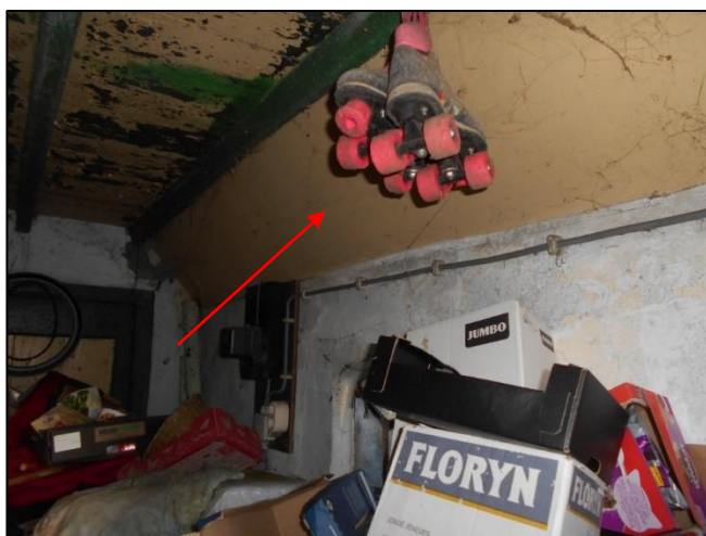
Foto 35: Woning 2: Bergruimte: Vlakke plaat (M04AA)
