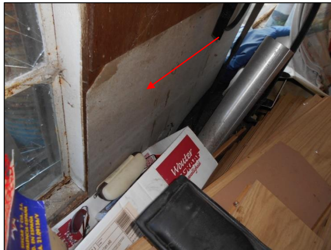
Foto 50: Schuur 1: Binnenzijde: Vlakke plaat (M04AZ)
