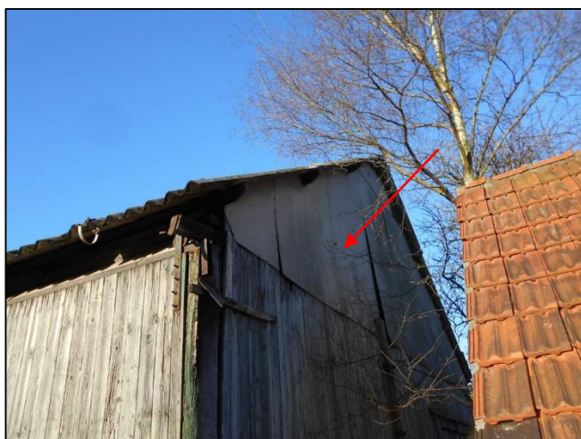
Foto 59: Schuur 2: Buitenzijde: Wandbeplating (M04AZ)
