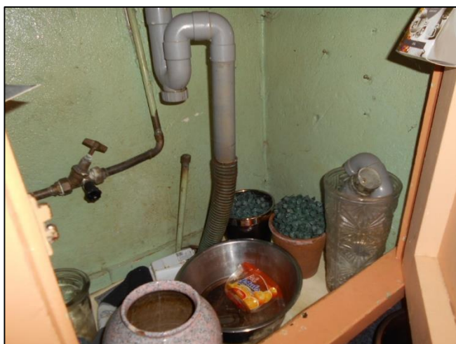
Foto 23: Woning 1: Keuken: Afvoer (PVC)
