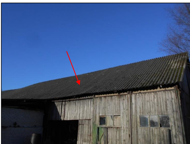
Foto 53: Schuur 2: Golfplaten dak (M03AZ)
