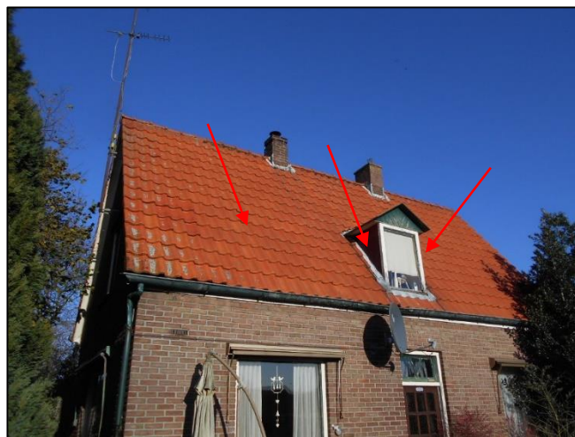
Foto 14: Woning 1: Dakbeschot en zijwangen dakkapel (M02AA)
