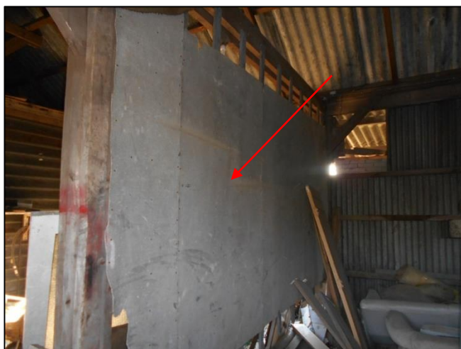
Foto 57: Schuur 2: Binnenzijde: Wandbeplating (M04AZ)
