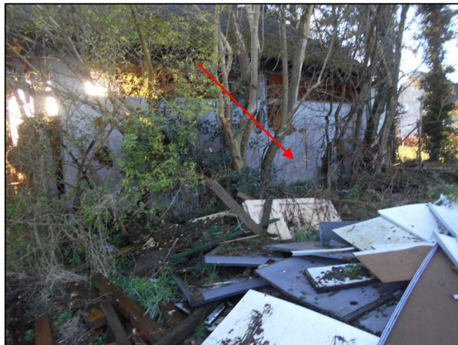
Foto 62: Schuur 2: Buitenzijde: Wandbeplating (M04AZ)
