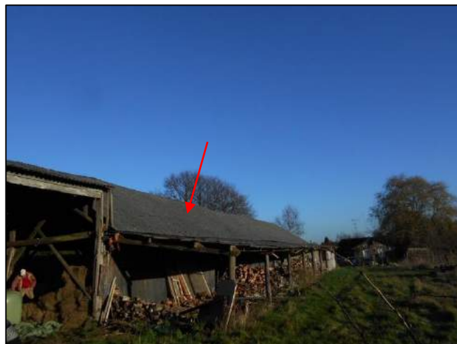
Foto 64: Schuur 2: Golfplaten dak (M03AZ)
