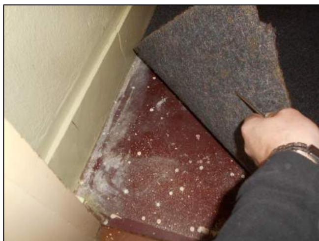
Foto 24: Woning 1: Onder vaste vloerafwerking
