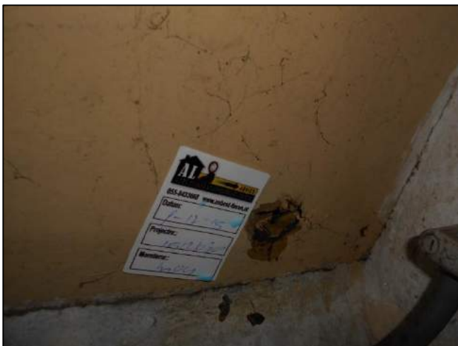
Foto 33: Woning 2: Bergruimte: Vlakke plaat (M04AA)
