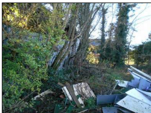
Buitenzijde schuur 2: Restanten wandbeplating (M04AZ)
