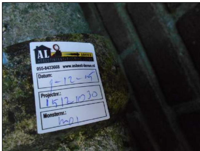
Foto 6: Afgebrande woning: Rookgasafvoer (M01AA)
