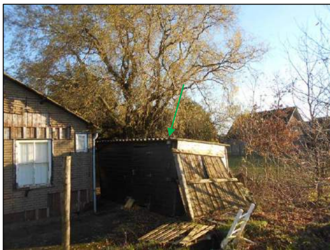
Foto 67: Schuur naast woning 4: Golfplaten dak (Asbestvrij)
