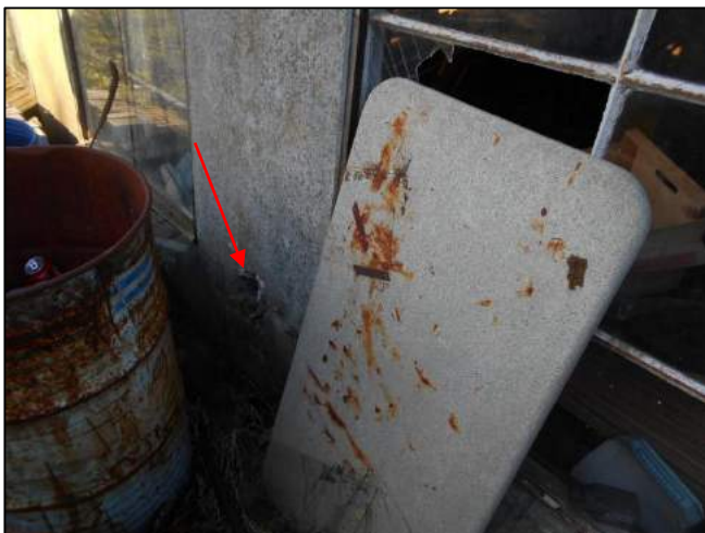
Foto 51: Schuur 1: Buitenzijde: Buis (M01AZ)
