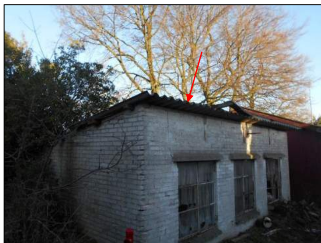
Foto 70: Schuur 3: Golfplaten dak (M03AZ)
