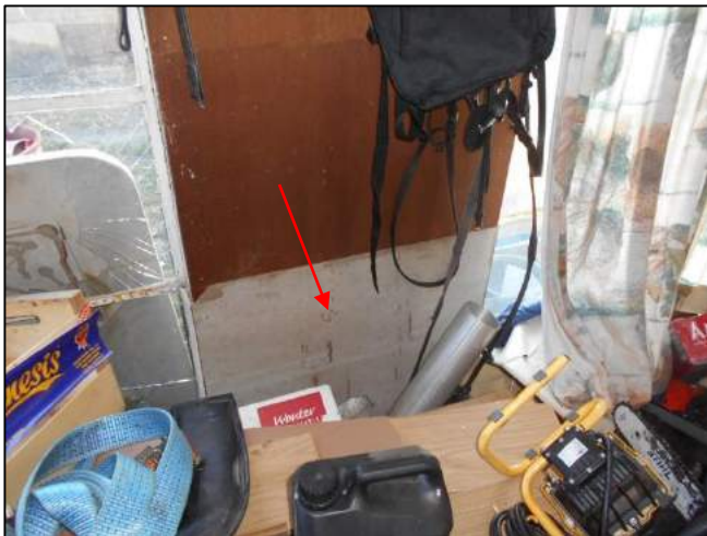
Foto 49: Schuur 1: Binnenzijde: Vlakke plaat (M04AZ)
