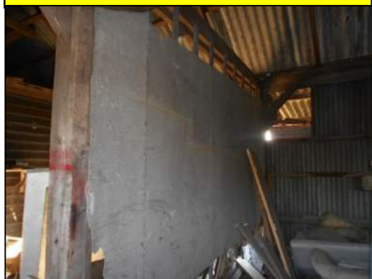
Binnenzijde schuur 2: Wandbeplating (M04AZ)
