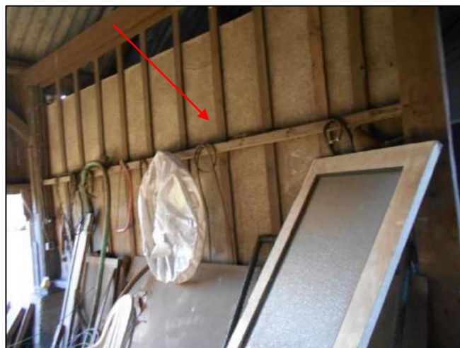
Foto 56: Schuur 2: Binnenzijde: Wandbeplating (M04AZ)
