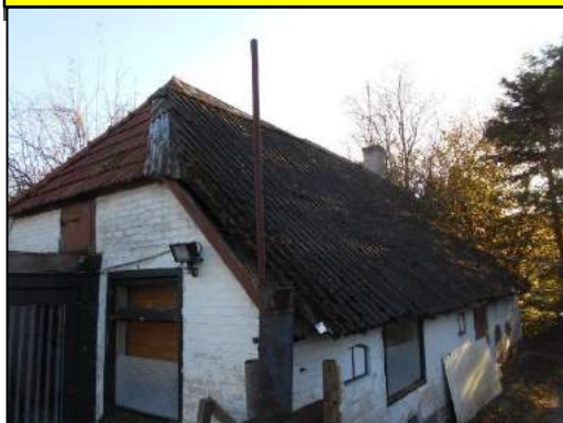
Woning 2: Golfplaten dak en afdak (M03AA)
