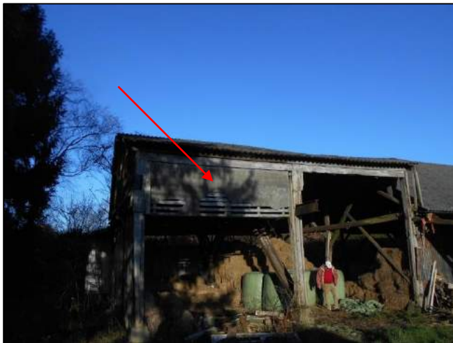
Foto 61: Schuur 2: Buitenzijde: Wandbeplating (M04AZ)
