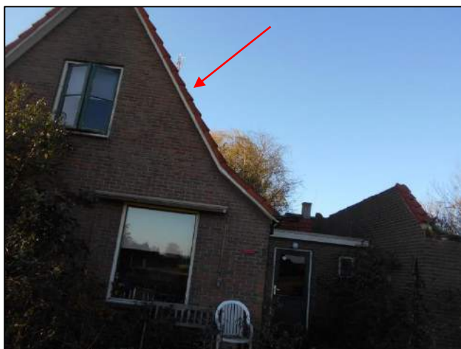
Foto 15: Woning 1: Dakbeschot (M02AA)
