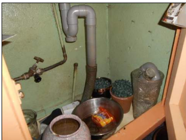
Foto 23: Woning 1: Keuken: Afvoer (PVC)
