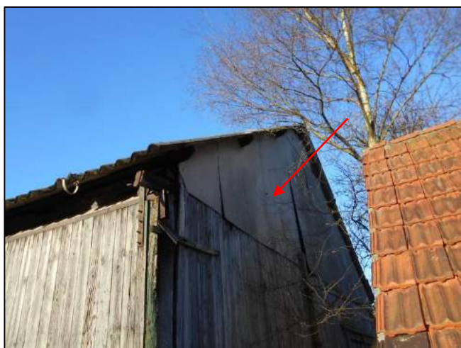
Foto 59: Schuur 2: Buitenzijde: Wandbeplating (M04AZ)
