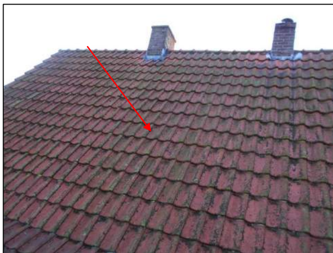
Foto 13: Woning 1: Dakbeschot (M02AA)
