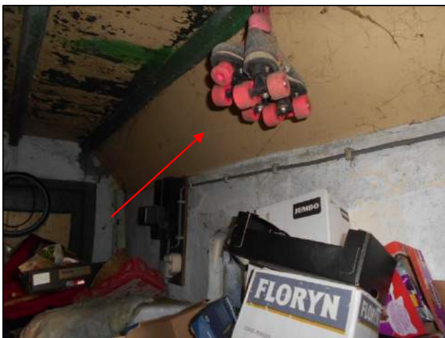
Foto 35: Woning 2: Bergruimte: Vlakke plaat (M04AA)
