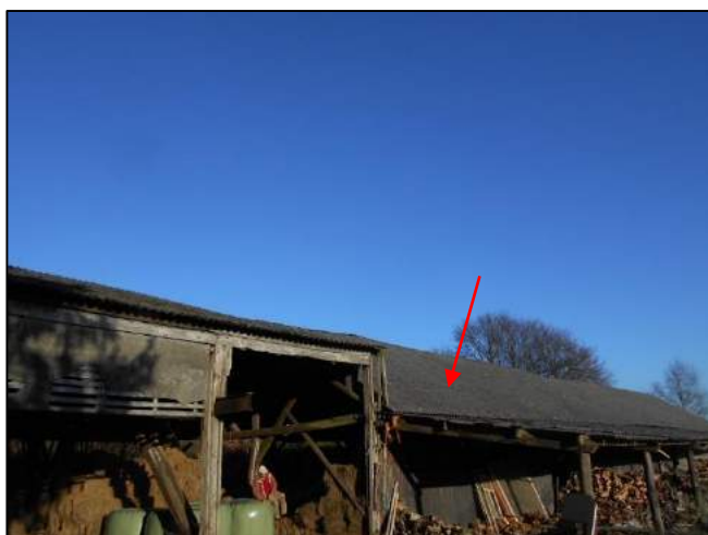
Foto 65: Schuur 2: Golfplaten dak (M03AZ)
