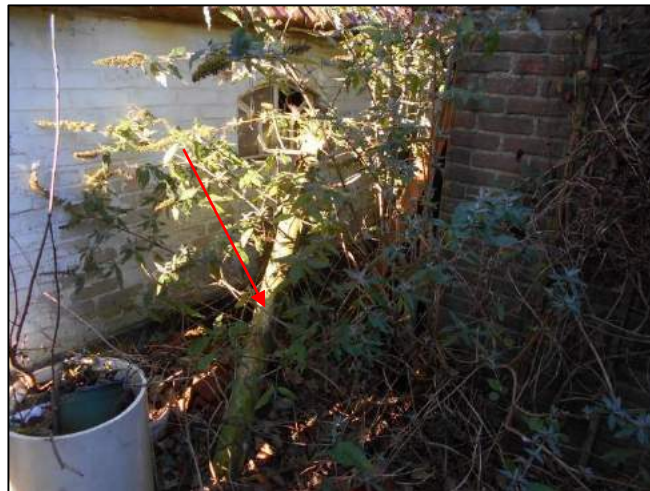
Foto 8: Naast afgebrande woning: Buis (M01AZ)
