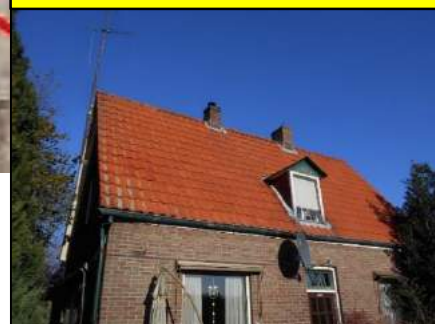
Woning 1: Dakbeschot en zijwangen (M02AA)
