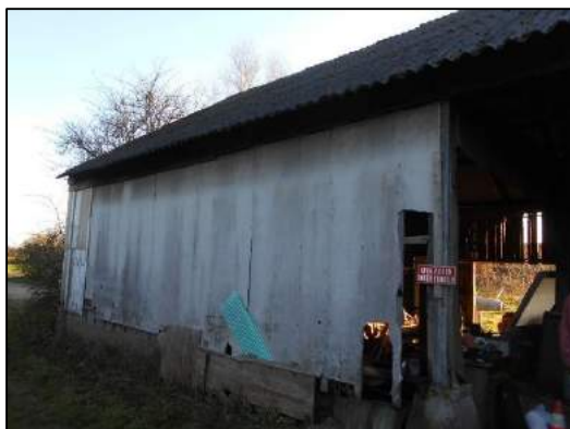
Buitenzijde schuur 2: Wandbeplating (M04AZ)
