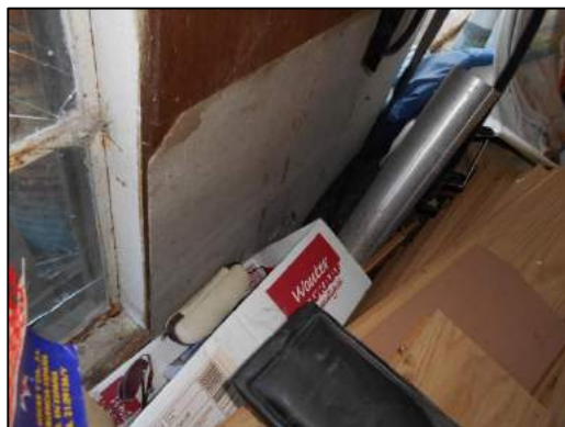
Binnenzijde schuur 1: Vlakke plaat (M04AZ)
