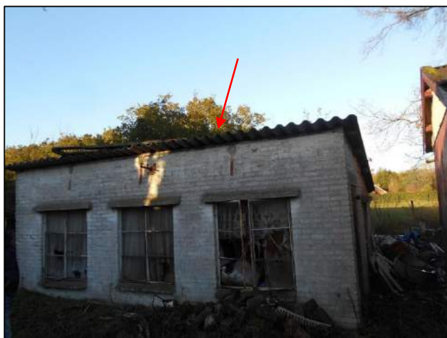
Foto 69: Schuur 3: Golfplaten dak (M03AZ)
