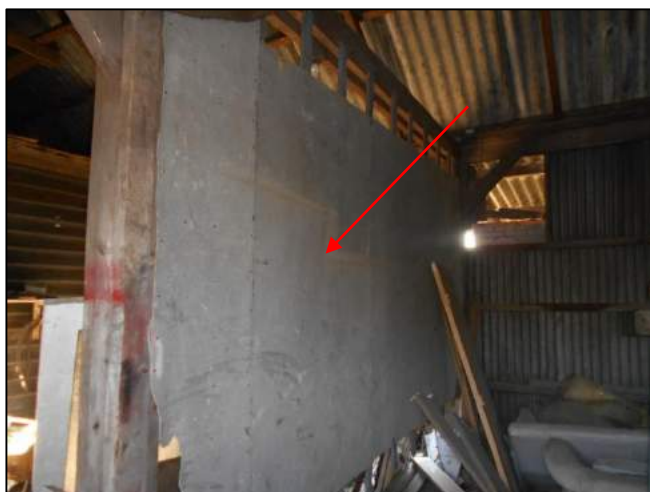
Foto 57: Schuur 2: Binnenzijde: Wandbeplating (M04AZ)
