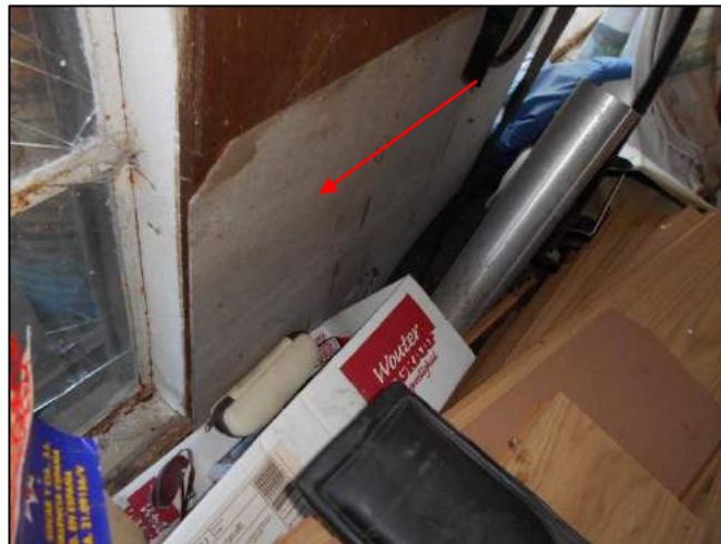
Foto 50: Schuur 1: Binnenzijde: Vlakke plaat (M04AZ)
