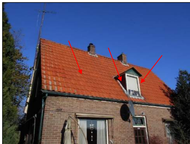
Foto 14: Woning 1: Dakbeschot en zijwangen dakkapel (M02AA)
