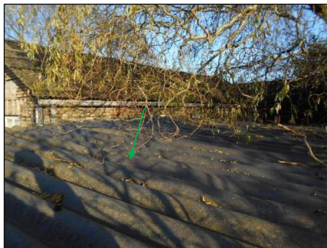
Foto 68: Schuur naast woning 4: Golfplaten dak (Asbestvrij)
