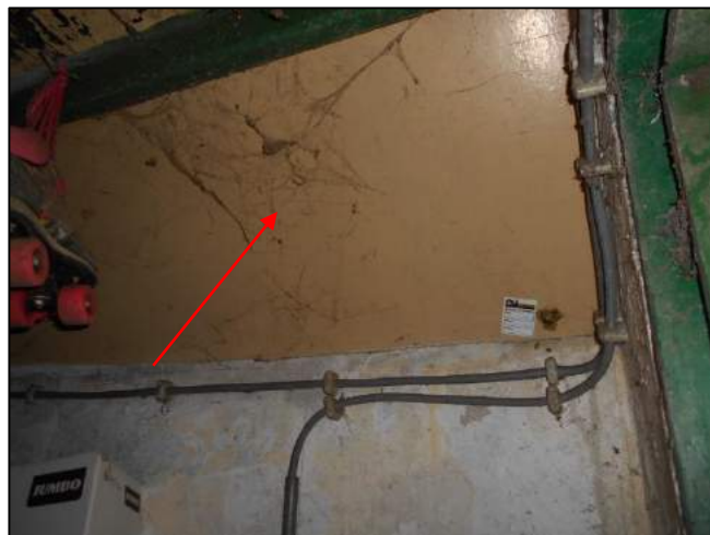
Foto 34: Woning 2: Bergruimte: Vlakke plaat (M04AA)
