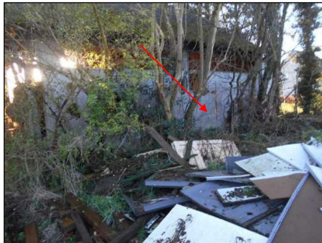
Foto 62: Schuur 2: Buitenzijde: Wandbeplating (M04AZ)
