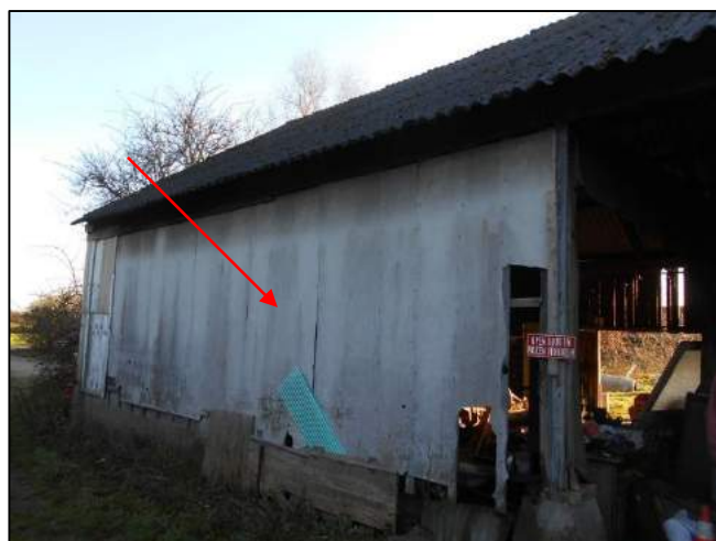
Foto 60: Schuur 2: Buitenzijde: Wandbeplating (M04AZ)
