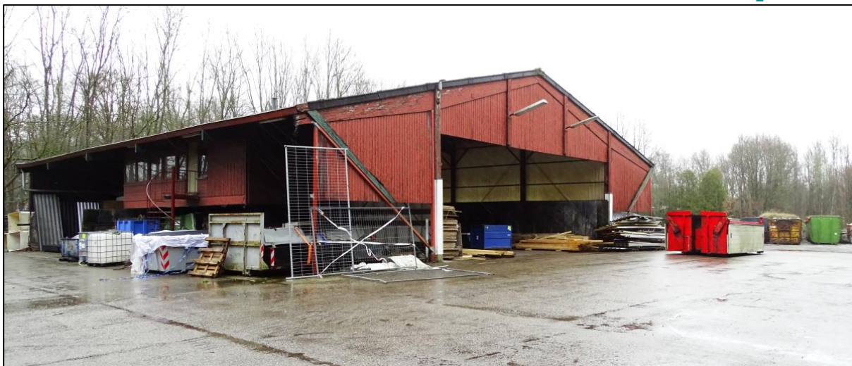
Figuur 2.2. Vooraanzicht van de voormalige zoutloods, gezien vanuit zuidwestelijke richting.
