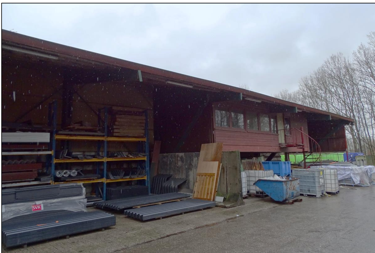
Figuur 2.3. Zijaanzicht van de voormalige zoutloods, gezien vanuit noordwestelijke richting.
