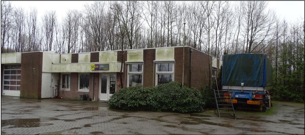
Figuur 2.6. Vooraanzicht van het gebouw van Nuon, gezien vanuit westelijke richting.
