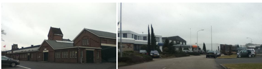
Afbeelding 2.4 Oudere en nieuwere bebouwing op het bedrijventerrein
