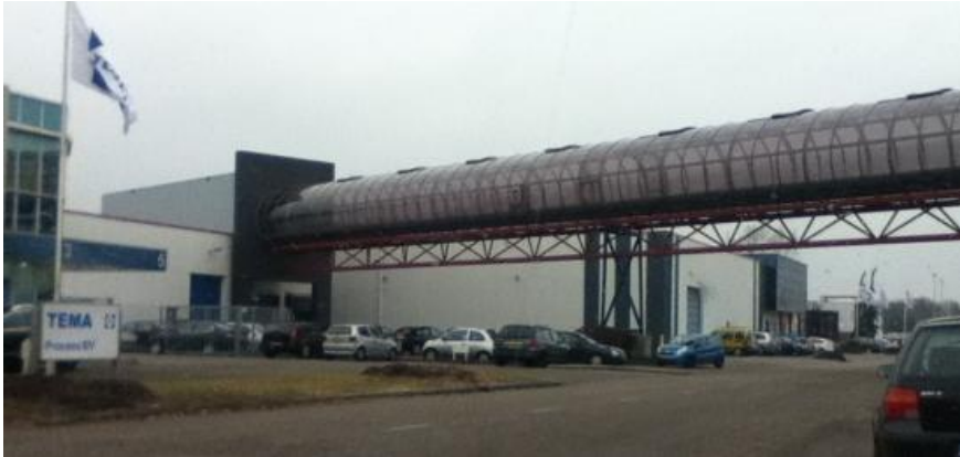
Afbeelding 2.6 Overkluizing op het bedrijventerrein
