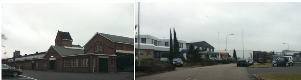
Afbeelding 2.4 Oudere en nieuwere bebouwing op het bedrijventerrein
