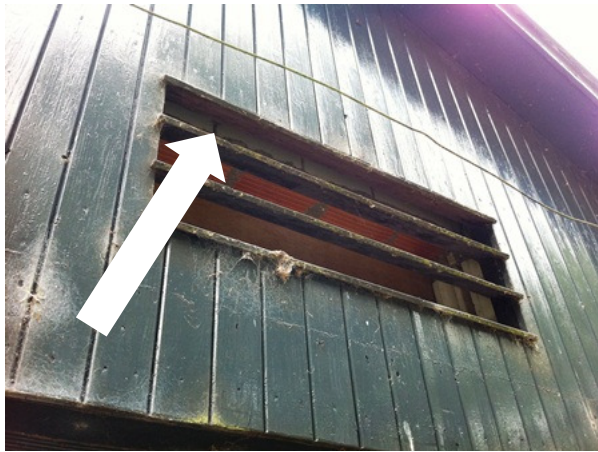
Potentiele invliegopening van vleermuizen; de verblijfplaats kan de spouw in de topgevel zijn.
