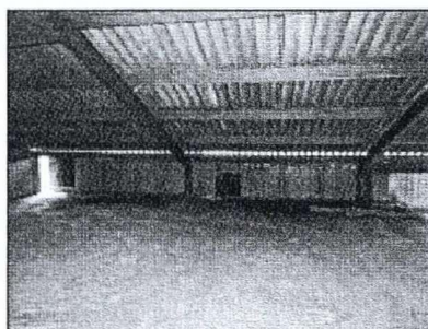
Figuur 7. Binnenzijde wagenloods.
