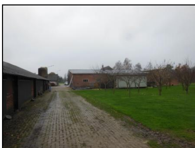
Figuur 6. Fruitbomen op erf en te slopen bebouwing.
