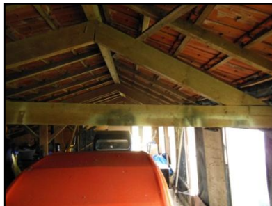
Figuur 4. Binnenzijde houten schuur.
