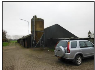
Figuur 5. Leegstaande varkensschuur.
