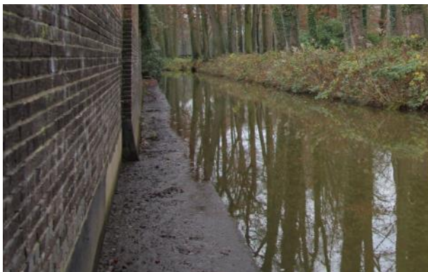
Betonnen rand langs de tuinmuur
