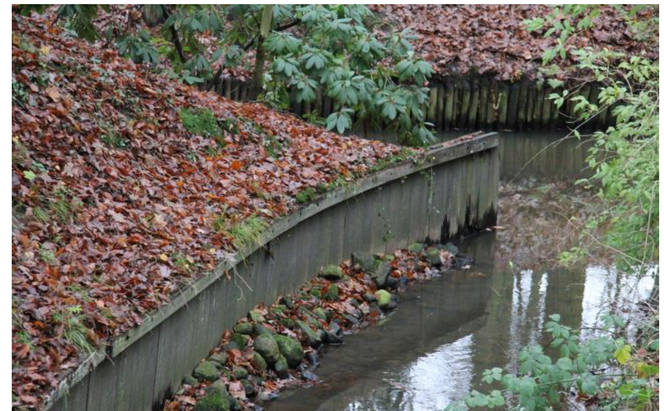
Er is gebruik gemaakt van verschillende typen beschoeiingen. Op de bovenste afbeelding is te zien dat de beschoeiing op enkele plekken in slechte staat verkeert.
