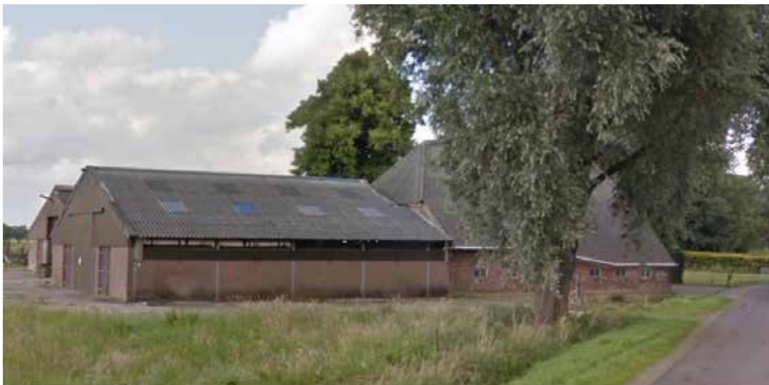
Te slopen stallen (1 en 2)
