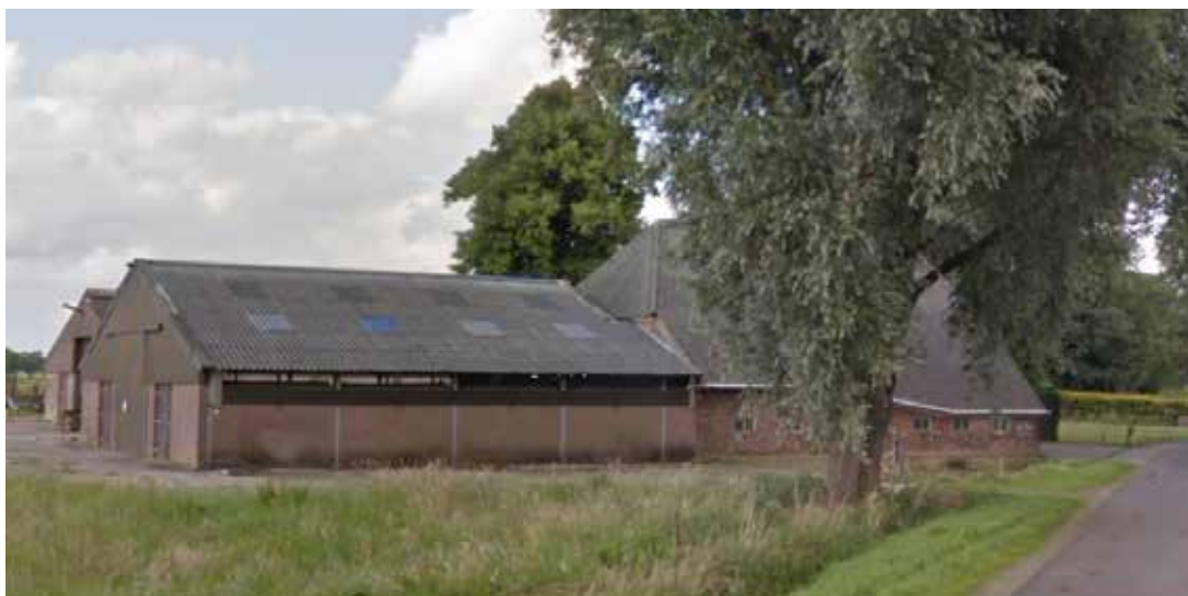
Te slopen stallen (1 en 2)
