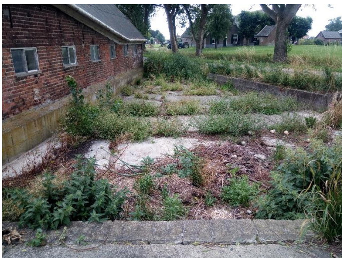
Figuur 10: Verlaagde bak (ca. 50 cm diep) met een put van ca. 1,1 m daaronder, foto vanuit het westen.
