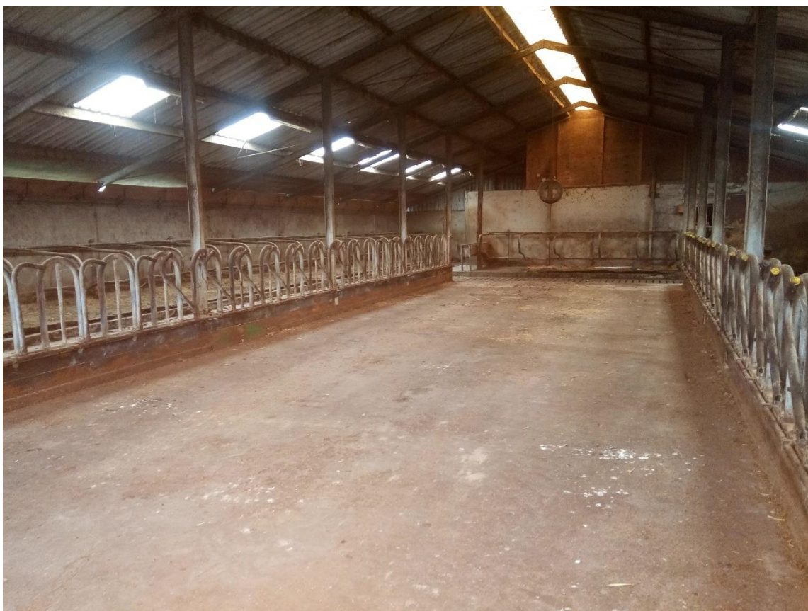
Figuur 11: Foto van de binnenkant van de noordelijke stal, genomen vanuit het westen.
