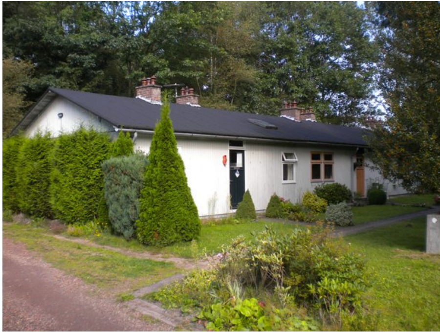
Houten woningen die gesloopt zullen worden
