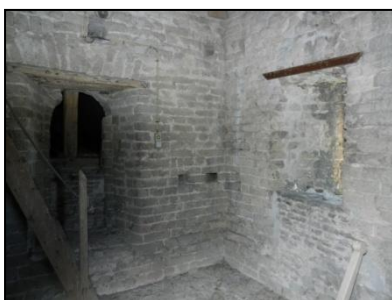
Figuur 11. Binnenzijde toren kerk.
