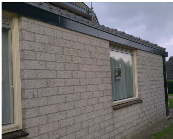
Afb. 3.1. De Rank met potentiële verblijfplaatsen achter gevelbetimmering.
