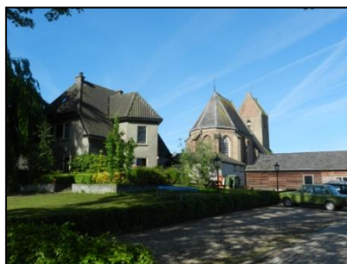
Figuur 7. Onderzoekslocatie gezien van het noordwesten.
