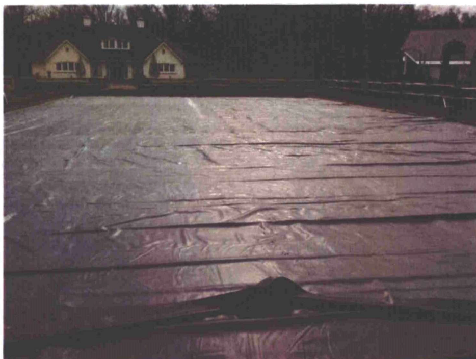
Dan wordt er een zwarte folie op de bodem gelegd (EPDM membraan).
