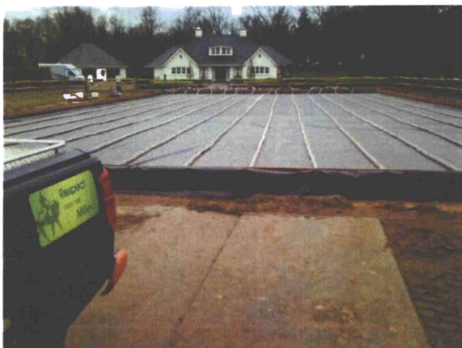
Hierop komen vele meters drainagebuis om het water aan- en af te kunnen voeren.
