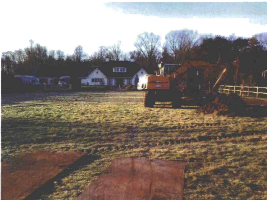
De rijplaten zijn gelegd en de graafwerkzaamheden kunnen beginnen.
