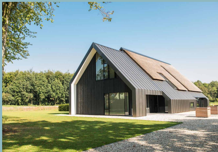
Referentiebeeld westelijk gelegen hoofdwoning
