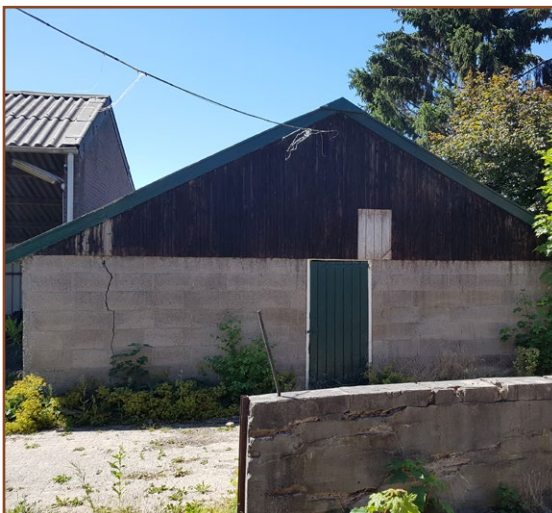
Afb. 2.4: De te slopen koeienstal (westzijde). In de koeienstal zijn meerdere huismussen nesten aanwezig. Ook is er een merel nest gelokaliseerd in de koeienstal. Tijdens het veldbezoek waren jonge merels aanwezig. Sporen van de Steenmarter ontbreken.
