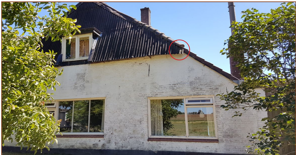
Afb. 2.1: Aanzicht van de te slopen woonboerderij. De gaten in het riet van de woonboerderij (rode cirkel) maken het geschikt voor huismussen en vleermuizen. Deze plekken kunnen gebruikt worden als zomer-, kraam- en paarverblijven. Tijdens het veldbezoek zijn ook invliegende huismussen waargenomen.
