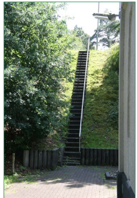
Foto 7: aanwezige trap ter indicering van het hoogte verschil. Aan de rechterzijde is de achterzijde van het pompgebouw zichtbaar. Aan de linkerzijde van de trap is de reinwaterkelder gepland.
