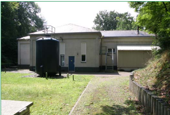
Foto 6: achterzijde van het huidige pompgebouw.
