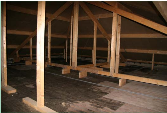
Foto 4: geheel gerenoveerde zolder op het huidige pompgebouw.
