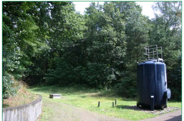
Foto 5: gegraven laagte aan de achterzijde van het pompgebouw. Aan de rechterzijde van de laagte is de nieuwe reinwaterkelder gepland.
