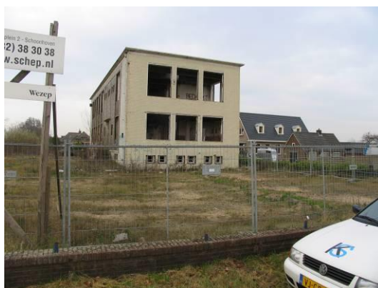
Huidige 'karkas' voorm. bedrijfsgebouw
