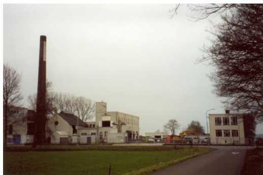
Foto van het voormalige fabrieksterrein
