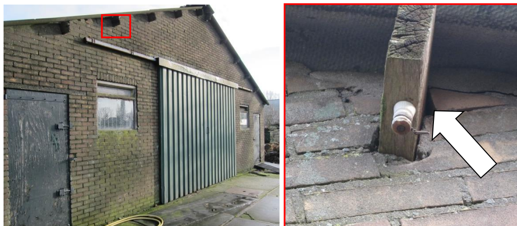
Afbeelding 4: Toegang voor vleermuizen tot de spouwmuur (foto's SAB, 2013)
